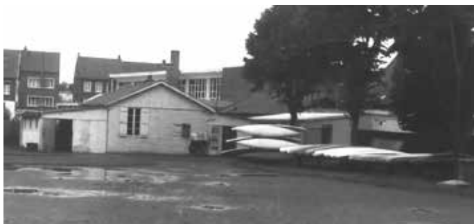
Au départ un baraquement sans eau ni chauffage
